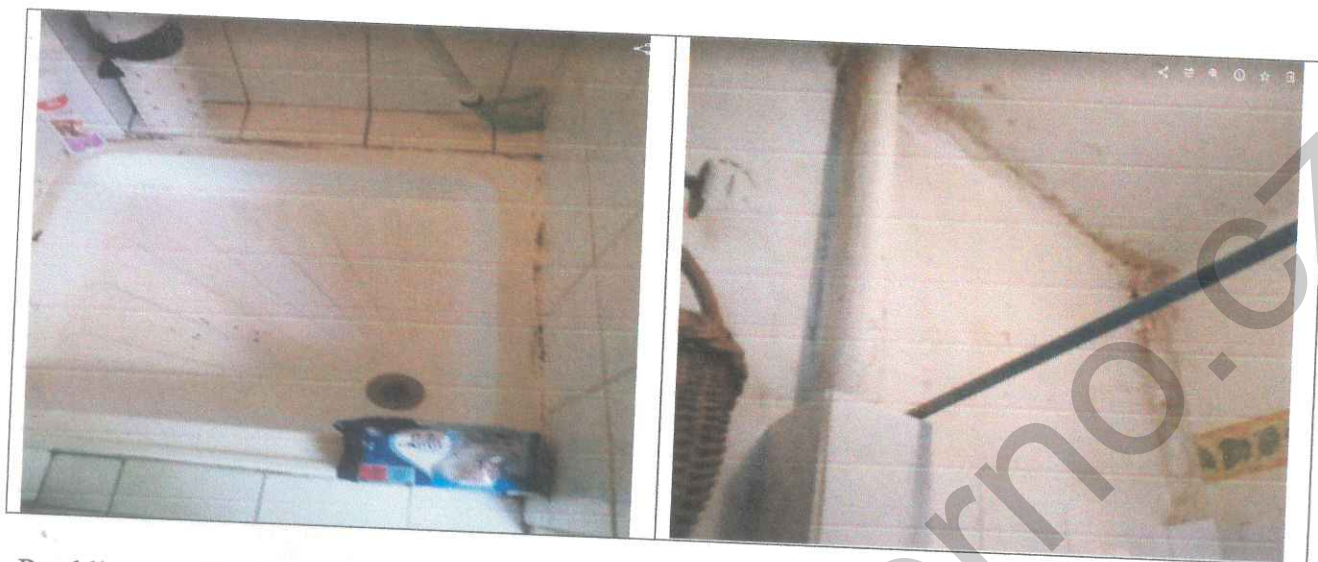
Elektrický bojler a patrná vlhkost a plíseň
